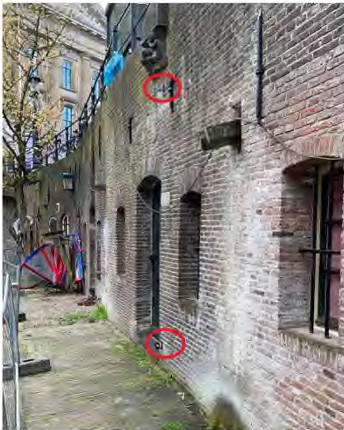
Figuur 4: Voorbeeldfoto positie prisma's (rood omcirkeld)
